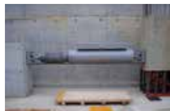
免震装置(オイルダンパー)
