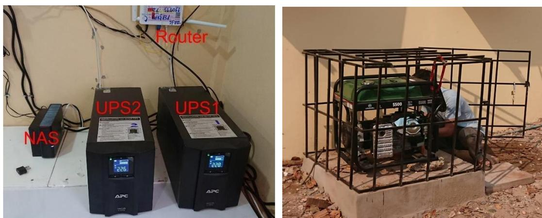
写真 16 無停電電源装置と非常用発電機
