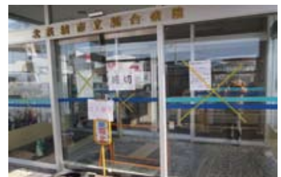
大きな被害を受けた北茨城市総合病院
