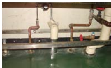
● 給湯管破損
