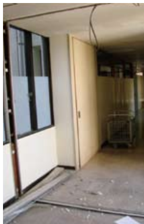
● 内部エクspansionジョイント部の破損
