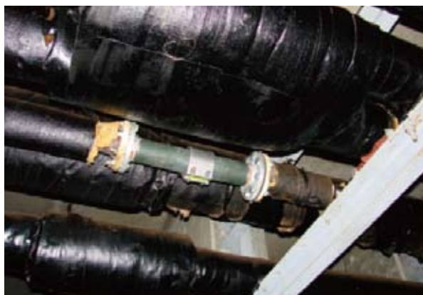
● 給湯管破損
