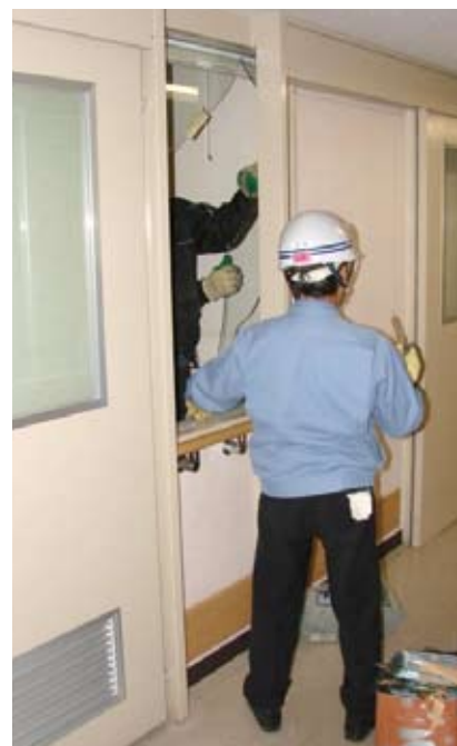
● ガラスの破損
