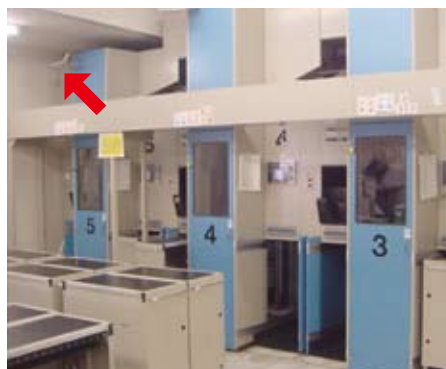
図3 左に3cmほどずれたため5号機上部が壁にめり込んだ5連結 SSP
