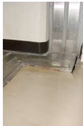
● 内部エクspansionジョイント部の破損
