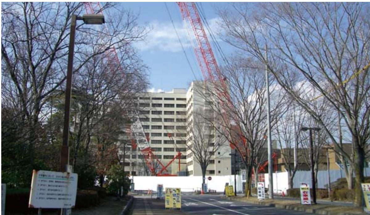
新病棟の建築現場（平成23年2月撮影）
