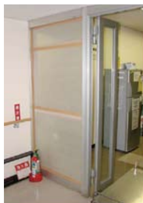
● 破損したガラスの応急処置
