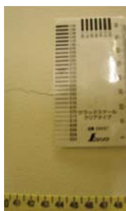
● 壁クラック幅の調査状況
