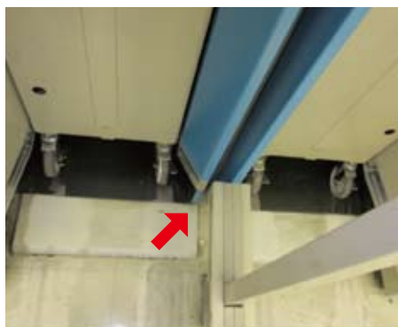
図3 左に3cmほどずれたため5号機上部が壁にめり込んだ5連結 SSP
