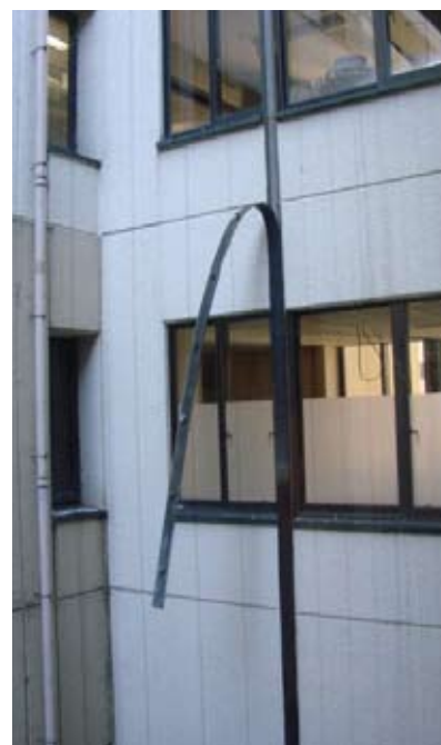
●エキスパンションジョイントのカバーが落下
