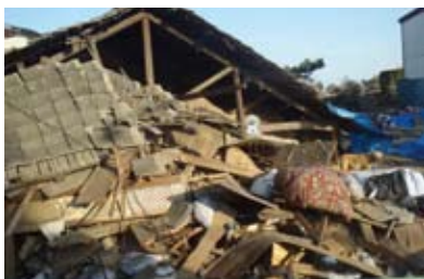
倒壊した民家
