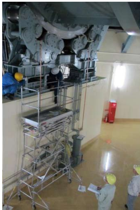
回転ガントリーの修理作業
