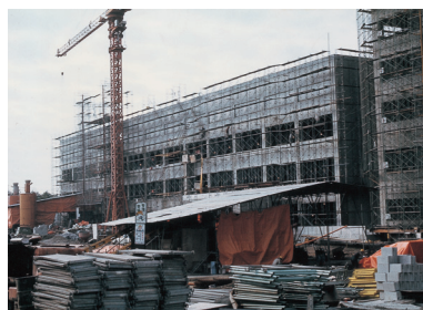
建築中の外来診療棟(昭和50年)
