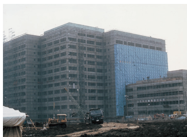
建築中の病棟(B棟)(昭和50年)
